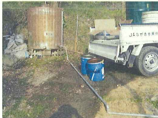
4. 地上配管への切り替え
