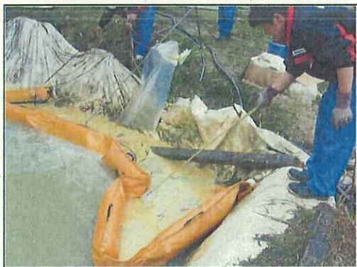
3. 重油の回収作業
